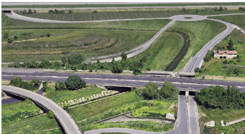
A sinistra: il nuovo tracciato di 1.350 metri dell'asse viario Sesto-Osmannoro tra le due nuove rotonde, con la parte in deviazione ed il tratto di sottopasso del sedime aeroportuale di 412 metri. A destra: simulazione grafica dello svincolo autostradale di Sesto Fiorentino e del tracciato dell'asse stradale Sesto-Osmannoro tra l'uscita del sottopasso della nuova pista (in alto a sinistra) e il sottopasso esistente dell'autostrada A11.
